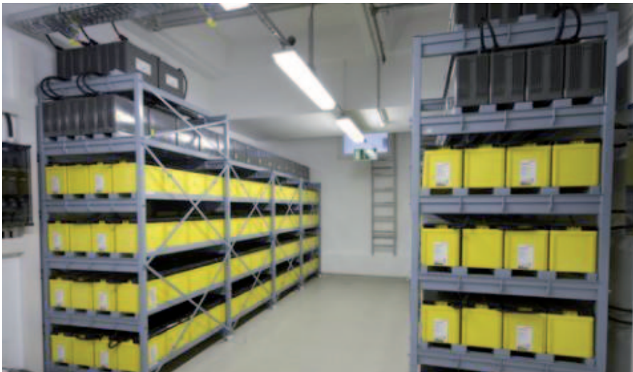
Getrennte Batteriestränge für sofortige Stromversorgung
