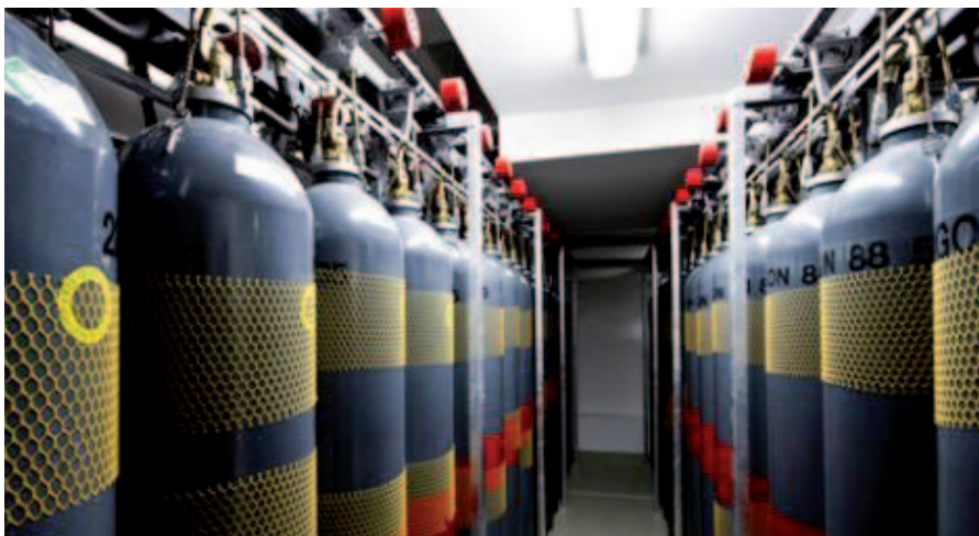
Argon-Löschanlage
